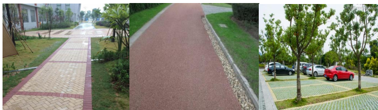
图 4.1.1-2 透水路面示例
